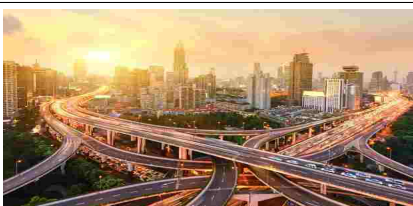
Kunta rakensi uutta risteystä
