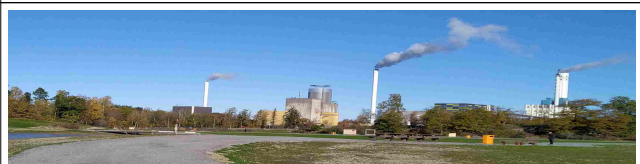
Jätteet antavat lämpöä Västeråsissa
