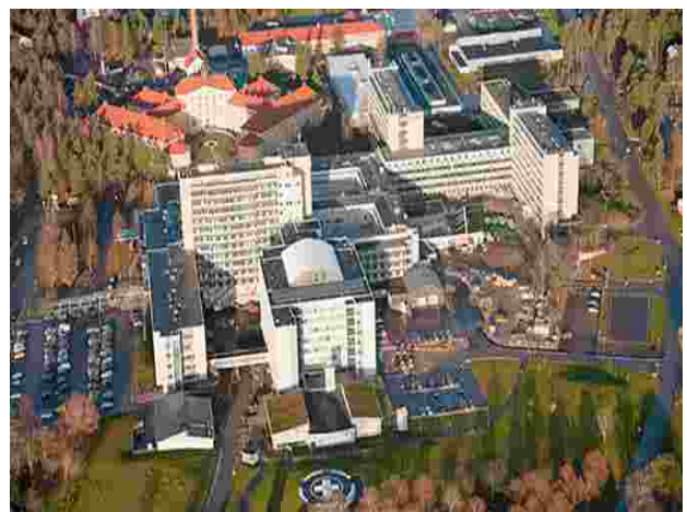
Västeråsissa rakennetaan uusi hätäkeskus Entisen "akutin" ja helikopterin väliin
